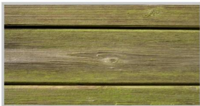
ظاهر سطح چوب قبل از اجرا
